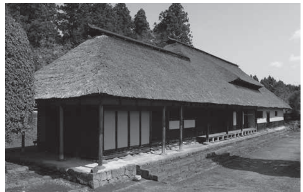
写真3 重要文化財我妻家住宅（主屋）
