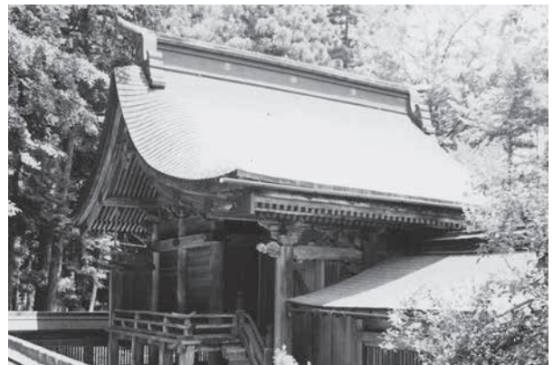
写真 14 刈田嶺神社本殿（享保 3 年 [1718 年] 建築）
