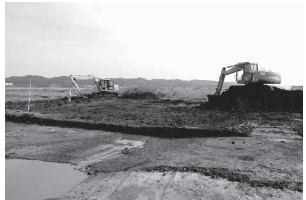
写真18 表土掘削作業（4区）
