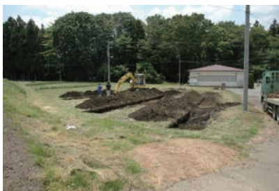
写真61 円田入B遺跡トレンチ掘削状況 (北西から)
