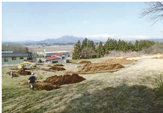
写真 53 トレンチ掘削状況（東から）
