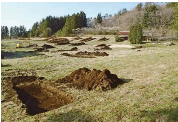
写真 52 トレンチ掘削状況（南から）
