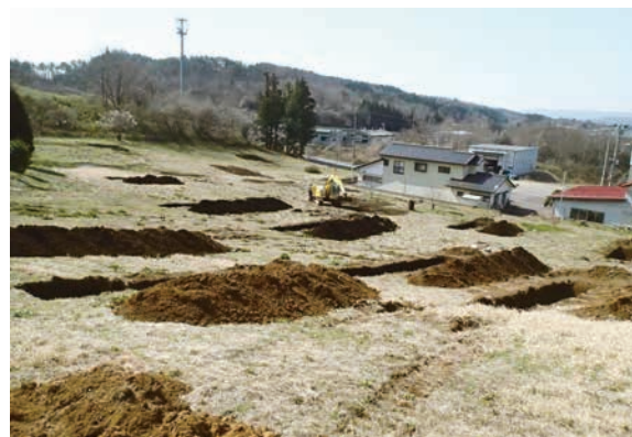
写真 51 トレンチ掘削状況（北から）
