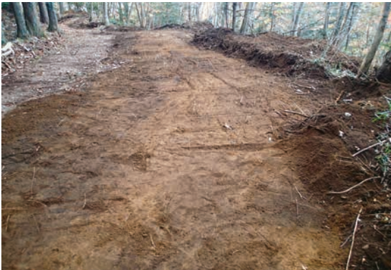
写真60 1トレンチ (東から)
