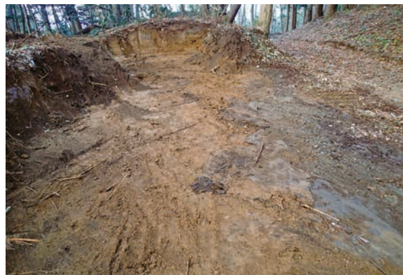
写真63 4トレンチ (南から)
