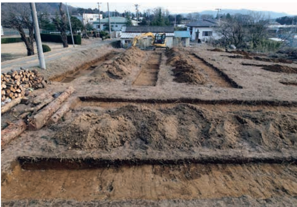
写真 49 上原田遺跡の確認調査 (北から)
