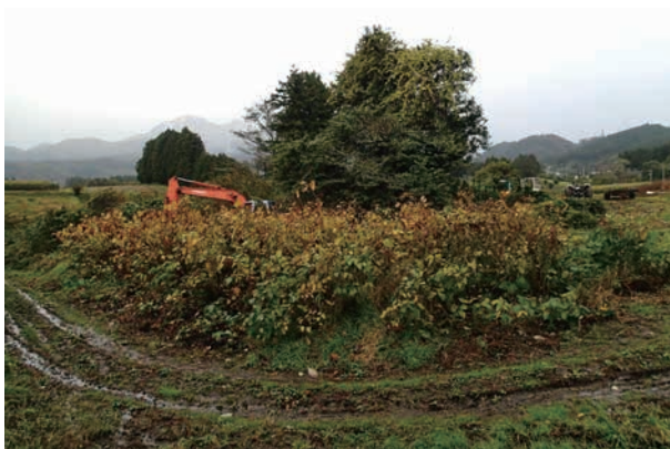
写真34 調査前現況 (北東から)
