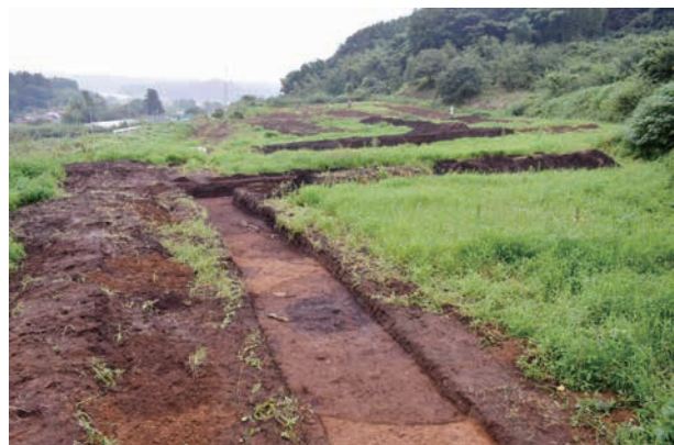
写真8 トレンチ掘削状況 (11トレンチ付近, 北から)
