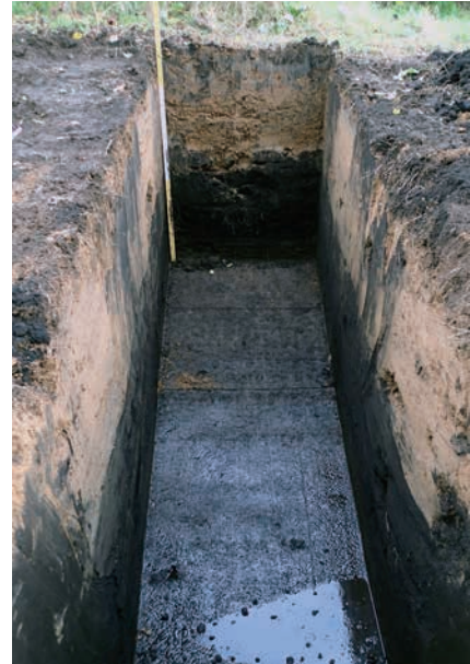
写真36 4トレンチ (西から)
