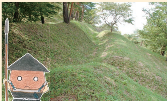
急勾配の土塁と空堀が館の守りを固める
