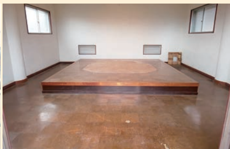
分解作業終了。床板の傷みが目立つ
