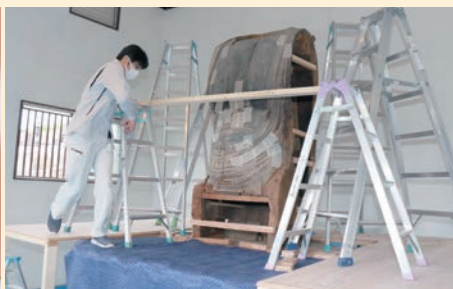
頭部を持ち上げるための足場を組む
