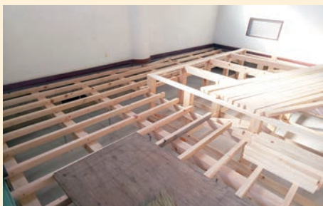
シロアリ予防剤を塗布した部材で造作
