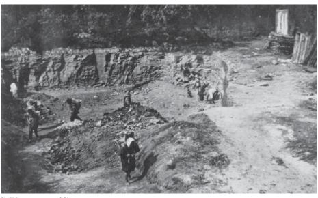
採掘場の様子 採掘は露天掘りで、上部を覆う地層を取り去って採掘しました。20か所ほどあった採掘場は最大で深さ18mに及び、崩落事故もある危険な作業でした。深度が増して露天掘りによる採掘が困難になってくると坑道掘りも行なわれましたが、効率が悪く採算性が低下し、昭和40年代に入ると採掘事業は相次いで停止されました。
